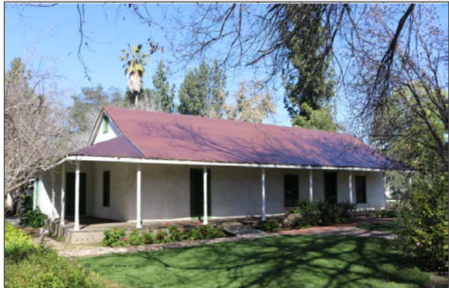
La Casa Primera - Roof Replacement
